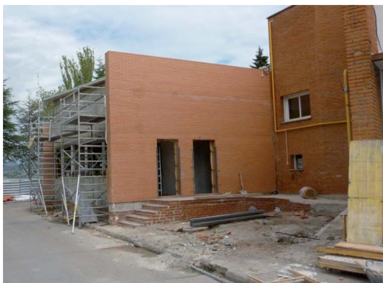
Construcción del nuevo comedor
