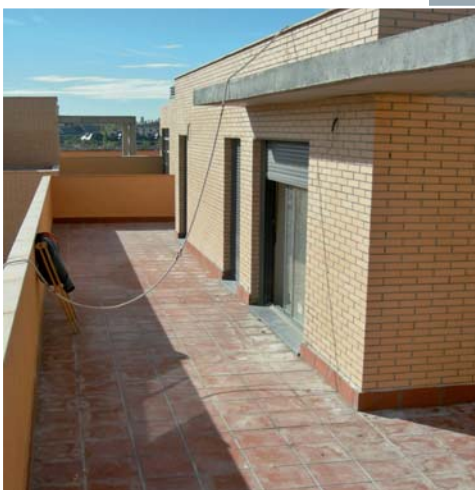
Viviendas VPPAOCJ en la parcela de “El Montecillo”
