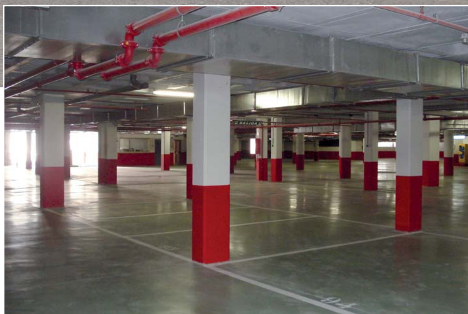
Interior del aparcamiento
